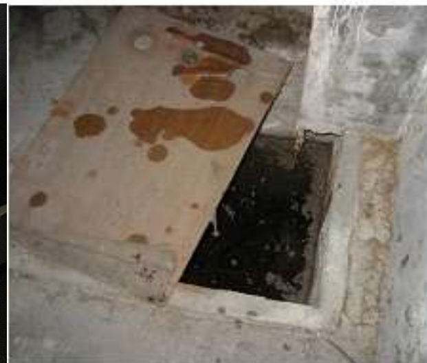
地下室汗水池
