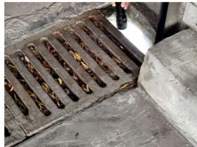
地下室車道水溝
